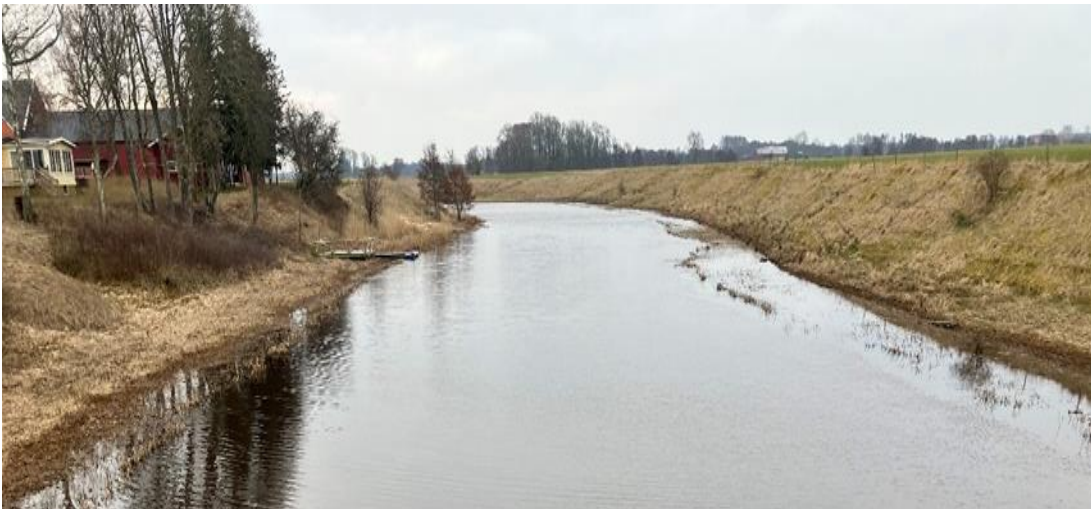
Provpunkt 790. Nossa, bron vid väg 2560.
