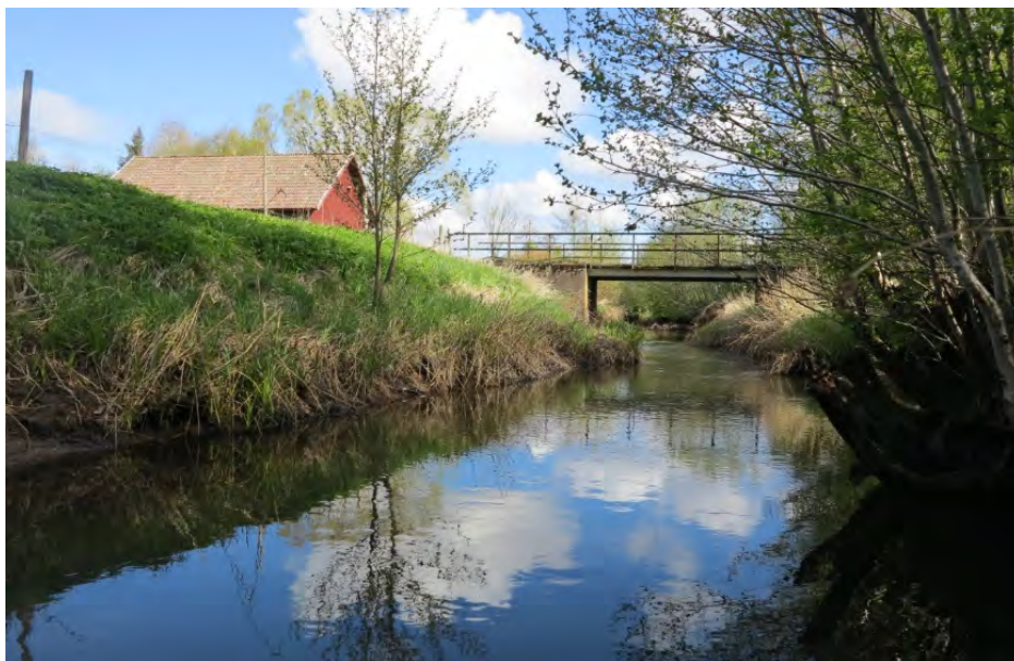
Figur L14 A G:a Reningsverket
