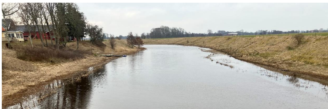
Provpunkt 790. Nossan, bron vid väg 2560.
